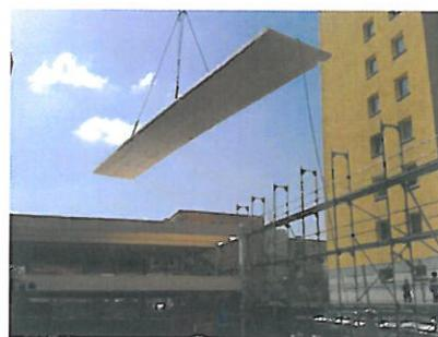
Abb. 18: Rohbau Montage BSP-Deckenelement (© Derix-Gruppe)
