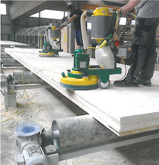
Holzbauteile wie etwa Decken wurden vor dem Einbau vorkonstruiert.
